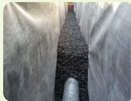
Отсыпка траншеи песком
